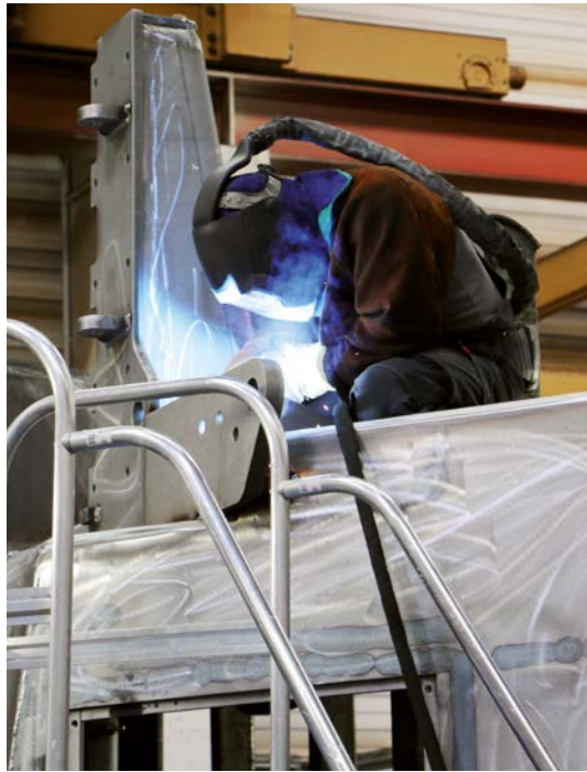
Das Erreichen des Einsatzortes bei großen Bauteilen, wie die sogenannten „Rops“, ist nur über eine Treppe möglich
