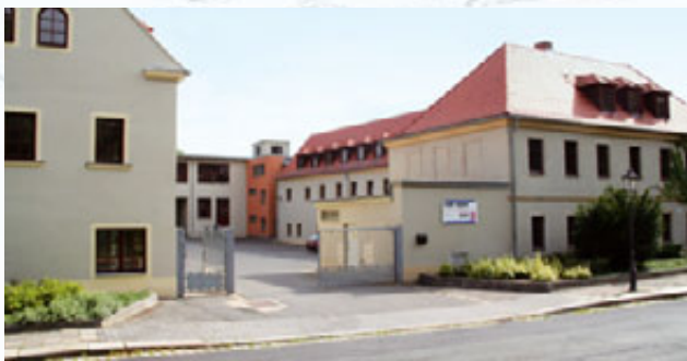
Nach wie vor bodenständig: der Firmensitz in Dresden-Löbtau.
