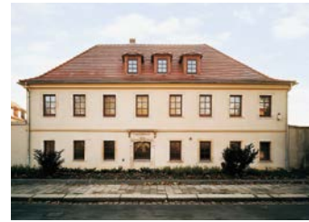
Ansicht des Firmenhauptgebäudes der KURT HAUFE Schweißtechnik
